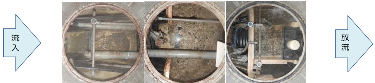
①沈殿分離槽 ②嫌気ろ床槽 ③好気ろ床槽 ④処理水槽及び消毒槽
