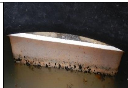
嫌気ろ床槽第1室移流口の様子
