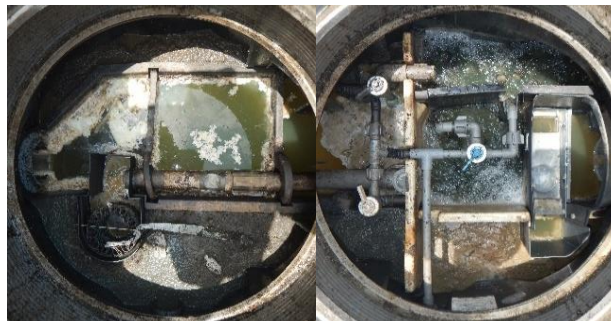
①汚泥貯留槽 ②担体流動槽 ③沈殿槽及び消毒槽
