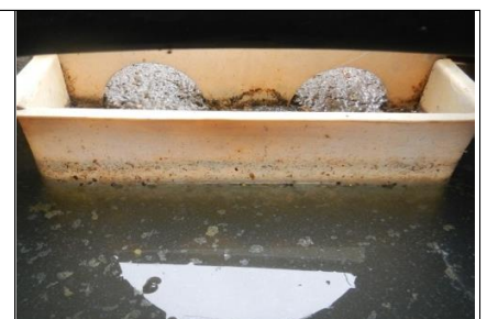
嫌気ろ床槽第1室移流口の様子
