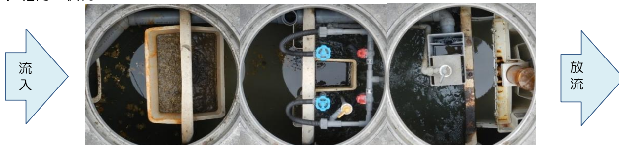
①嫌気ろ床槽第1室 ②嫌気ろ床槽第2室 ③接触ばっ気槽 ④沈殿槽及び消毒槽
