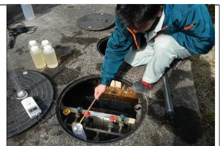
消石灰散布の様子
