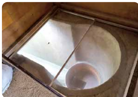
水洗厠舎の便槽内部
