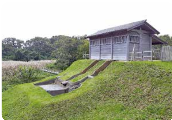
水洗厠舎の全景
