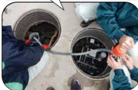
底部汚泥は嫌気ろ床槽1室に移送
