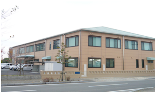
筑後検査センター増築後(外観)
