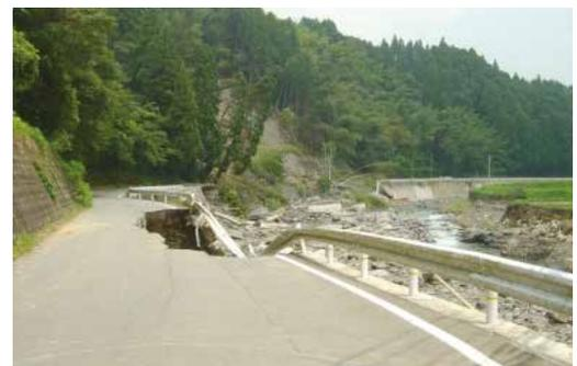
黒木町笠原地区の道路の陥没・崩落
