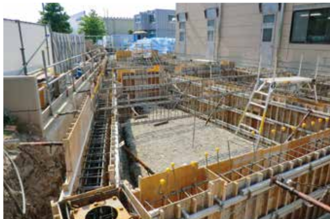
最新の工事状況
