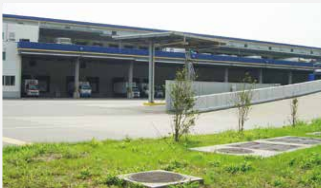
（工場、事務所に設置されている浄化槽の様子）
