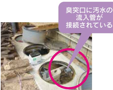
浄化槽上部のようす
