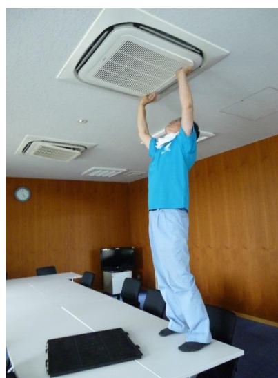
【エアコンフィルターの清掃】
